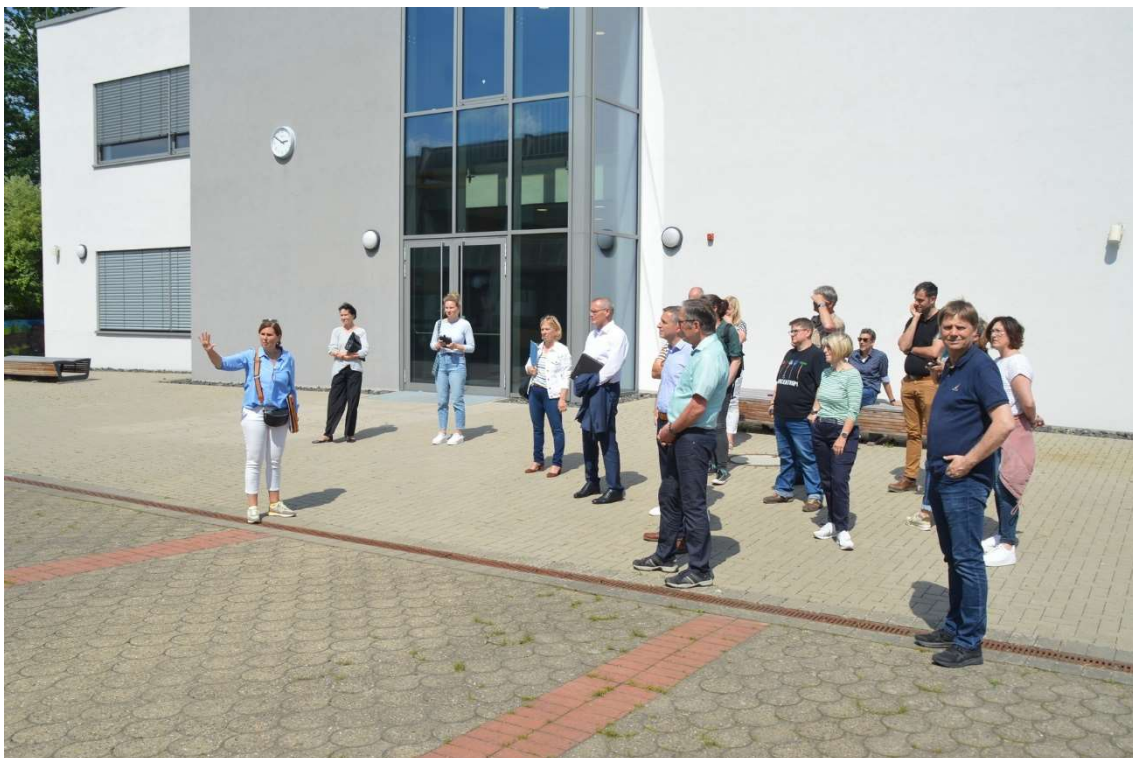
Architektin Birgit Braunschmidt (links), Schulverband-Geschäftsführerin Petra Vollmer (4. von links) und Schulverbandsvorsitzender Thomas Stamm (5. von links) führten durch die laufenden Sanierungsarbeiten an der Mittelschule.
